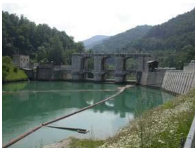
Slika 10: Dovodni kanal na Soči pred pregrado Ajba
