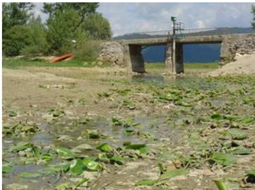
Slika 15: Merilno mesto na območju kopalnih voda Dolenje jezero – Otok v avgustu 2007 (pogled gorvodno)
