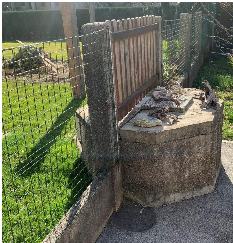
Slika 1. Merilna postaja Sojerjeva za spremljanje stanja podzemne vode na Ljubljanskem polju; marec 2020 Figure 1. Sojerjeva Measuring station for groundwater status observation of Ljubljansko polje, March 2020
